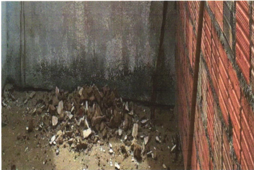
FOTO 13 – Demolição de reboco
