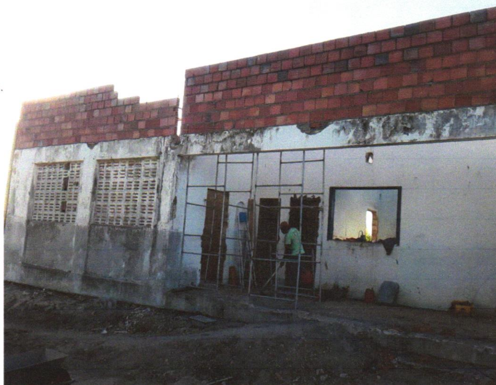
FOTO 06 – ALVENARIA DE VEDAÇÃO DE BLOCOS CERÂMICOS FURADOS NA HORIZONTAL DE 9X19X29 CM (ESPESSURA 9 CM) E ARGAMASSA DE ASSENTAMENTO COM PREPARO EM BETONEIRA. AF_12/2021
