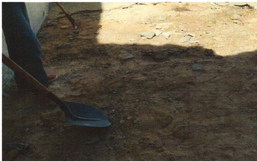
Foto 5 -Demolição manual de piso cimentado sobre lastro de concreto - Rev 01
