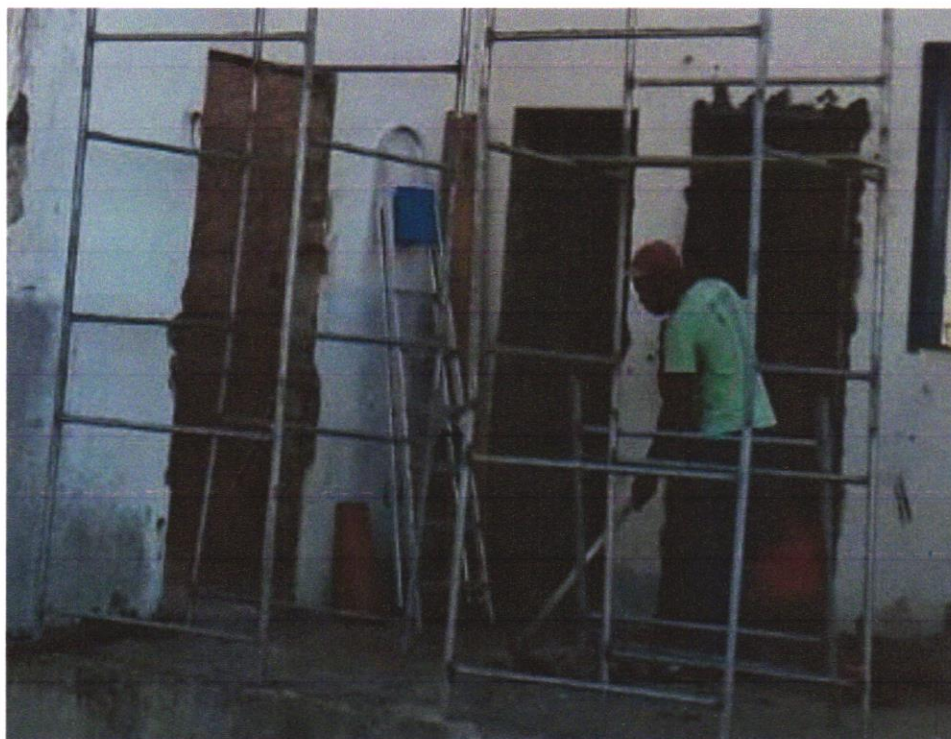
FOTO 15 Remoção de portas, de forma manual, sem reaproveitamento. af_12/2017
