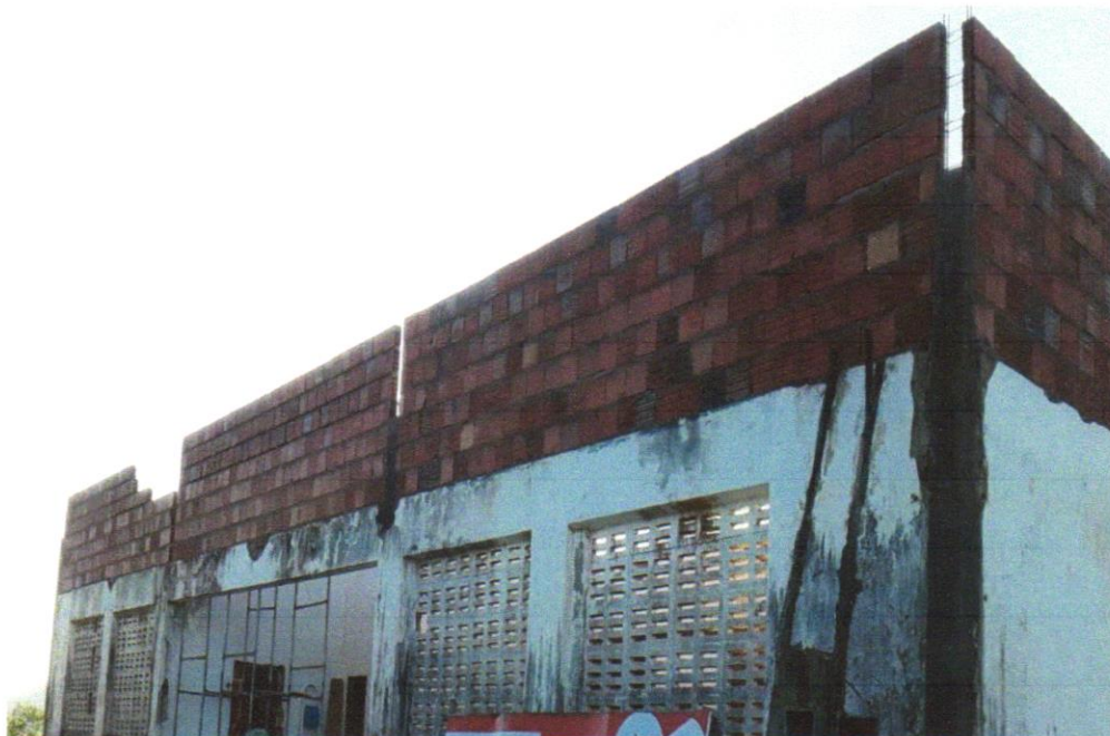
Foto 07 – ALVENARIA DE VEDAÇÃO DE BLOCOS CERÂMICOS FURADOS NA HORIZONTAL DE 9X19X29 CM (ESPESSURA 9 CM) E ARGAMASSA DE ASSENTAMENTO COM PREPARO EM BETONEIRA. AF_12/2021
